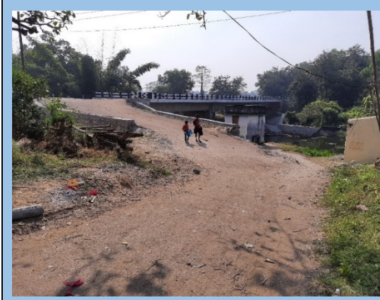
चित्र 2.11: धनबाद जिला के बारडुबी से लखरखवारी ग्राम के बीच पुल के पहुँच पथ पर तीखा मोड़ (90 डिग्री)
