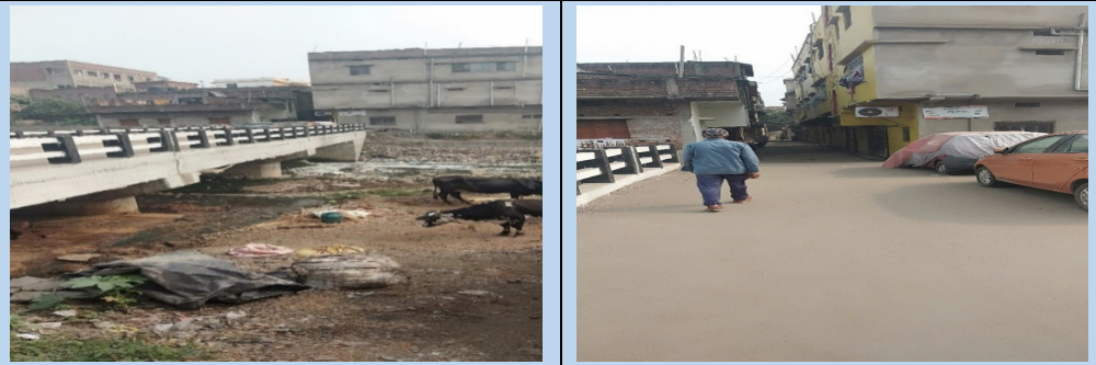
चित्र 2.4: धनबाद शहर के शहरी क्षेत्र में मु.मं.ग्रा.से.यो. पुल और पुल के डिज़ाइन में स्थित भवन (संयुक्त भौतिक सत्यापन 27 नवम्बर 2019 को हुआ)
