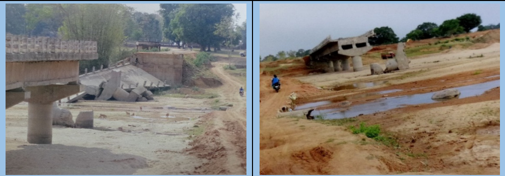
चित्र 2.9: सिसई प्रखंड में बालखटंगा-लोरेनगो सड़क के बीच दक्षिणी कोयल नदी पर बने ढहे पुल की तस्वीर
