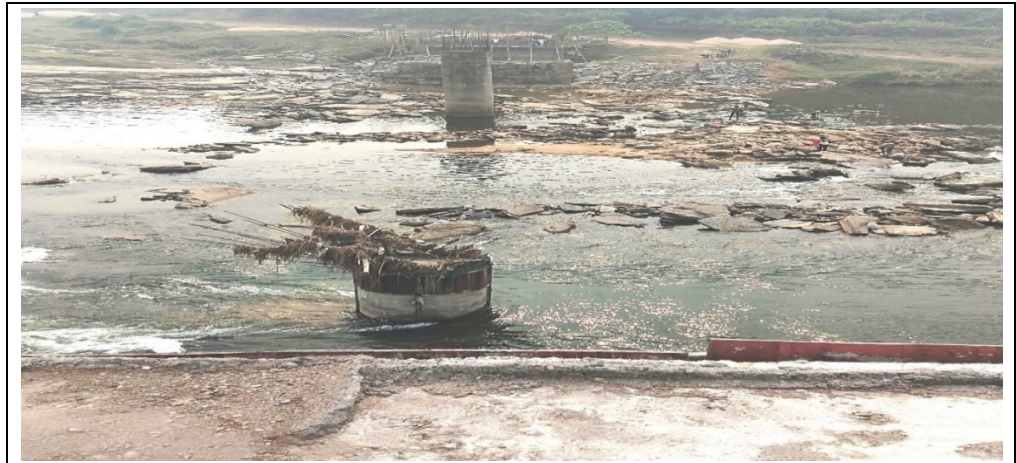
चित्र 2.15: धनबाद में गांसाडीह-सुइयाडीह पथ के बीच दामोदर नदी पर पुल में आंशिक रूप से निर्मित उपसंरचना पी9, पी11, पुराना ए2 (ध्वस्त होने वाला) एवं निर्माणाधीन एर
